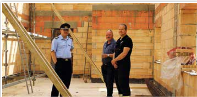
Ortswehrführer Christian Schwachheimer zeigt die neue Fahrzeughalle.
